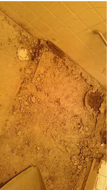
スラナー部3cm・袖壁一部7cm 取り解体
