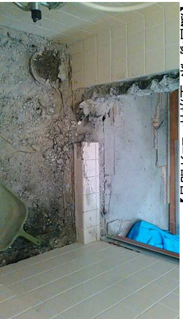
【風呂場・床・壁解体 ユニ配管】
