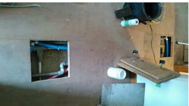
【各所給湯・給水配管工事 キッチン流し・ガス台交換】
