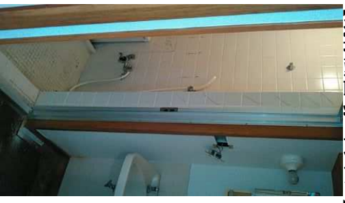
【既存風呂場・キッチン】
