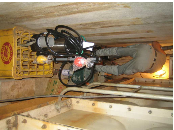
排水ポンプ・ゲート弁・逆止弁・電極警報機撤去, 交換
