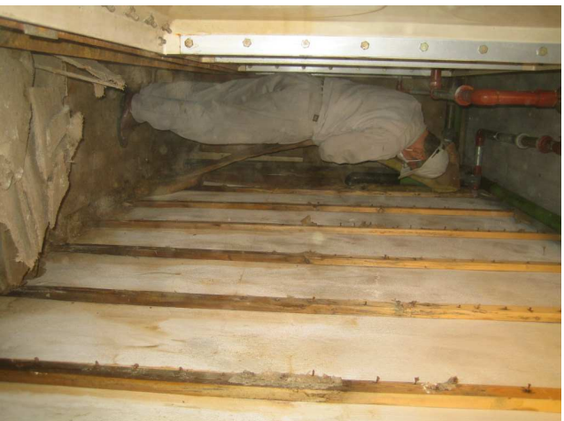
既存壁材(木下地+グラスウール+珞珞ス) 撤去中
