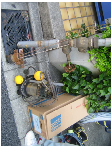
排水ポンプ・ゲート弁・逆止弁・電極警報機撤去, 交換
