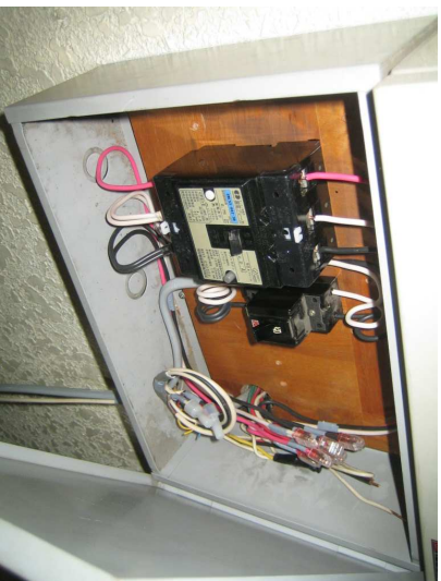
漏電ブレーカー交換・警報取付 (既存警報盤はそのままです)
