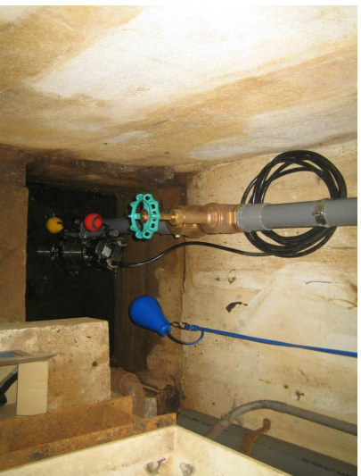
新規排水ポンプ・ゲート逆止弁・警報フロート(浮球)スイッチ取付
